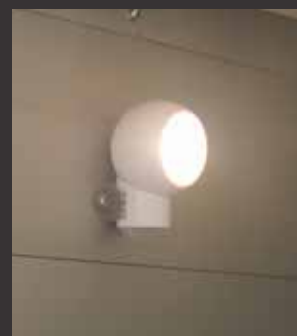
Éclairage intérieur à LED pour la sellerie
