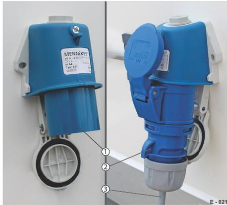
Abb. 23 Netzanschluss, extern
