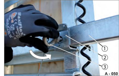
Abb. 72 Querstange lösen
